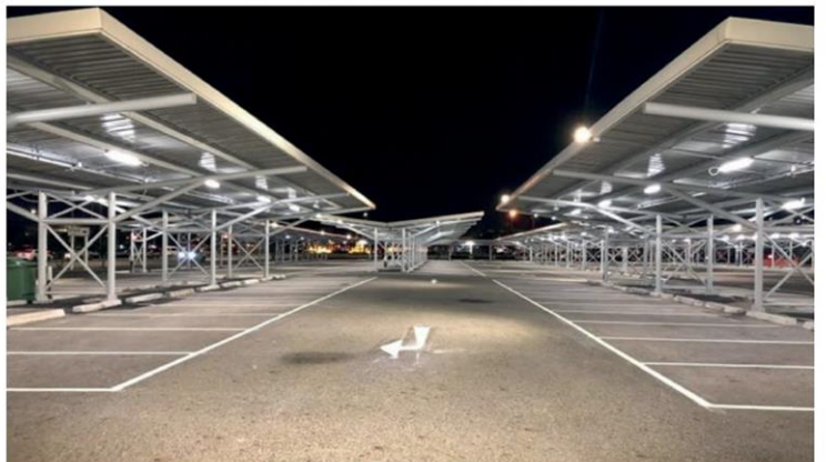
ติดตั้งหลังคาลานจอดรถระยะยาวโซน A
